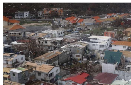
...après le passage d'Irma
